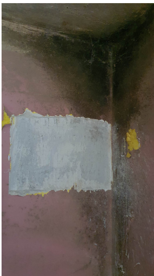
FOT. NR 6 – Odkrywka nr 4 - sprawdzenie warstw ściany od wewnątrz w pom. nr 4
