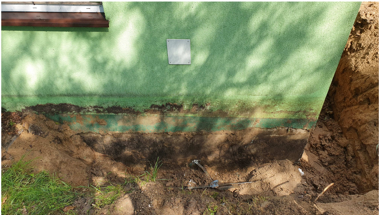
FOT. NR 1 – Odkrywka nr 1 wykop do głębokości 0,9 m w południowo-wschodnim narożniku ściany fundamentowej
