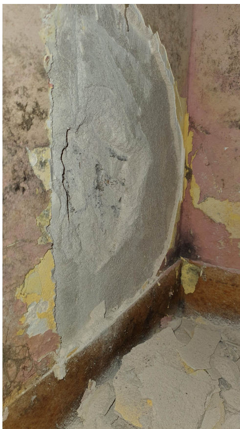
FOT. NR 5 – Odkrywka nr 3 - sprawdzenie warstw ściany od wewnątrz w pom. nr 4
