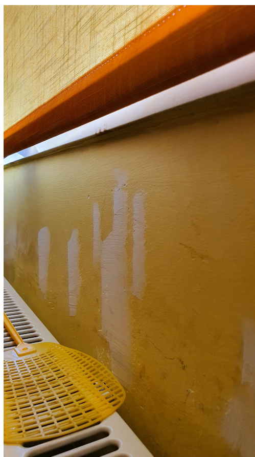
FOT. NR 18 – zaszpachlowane ubytki powłoki malarskiej - pom. nr 5
