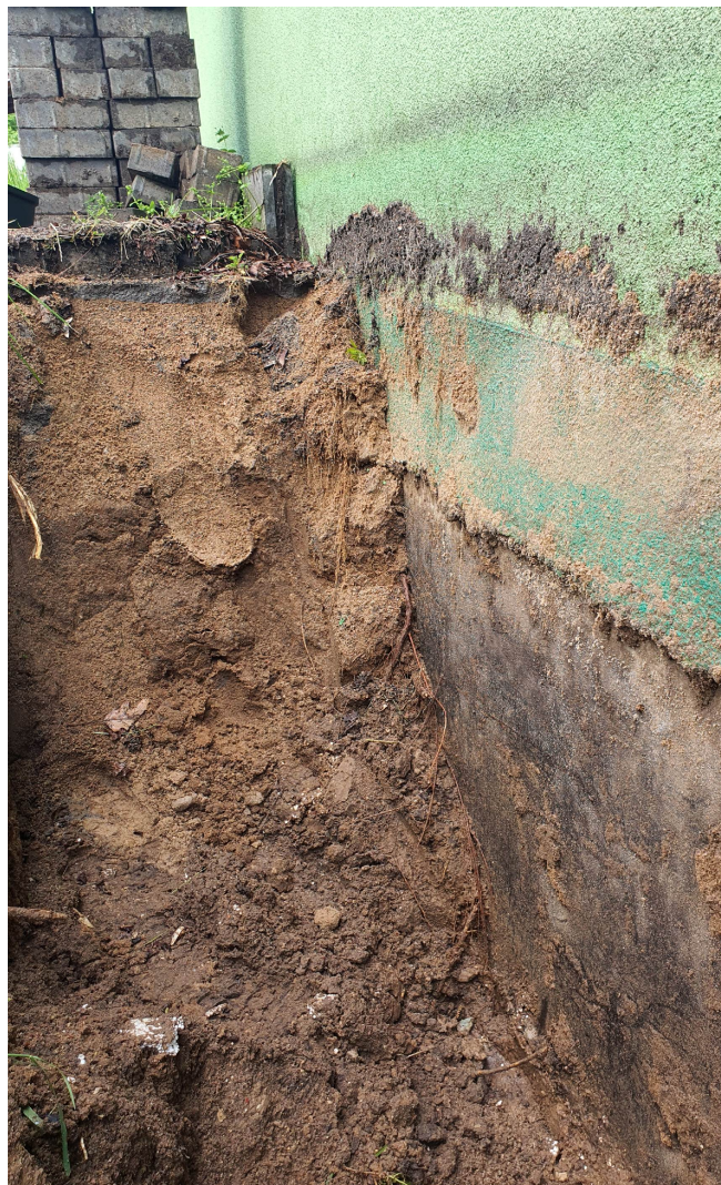
FOT. NR 2 – Odkrywka nr 1 wykop do głębokości 0,9 m w południowo-wschodnim narożniku ściany fundamentowej
