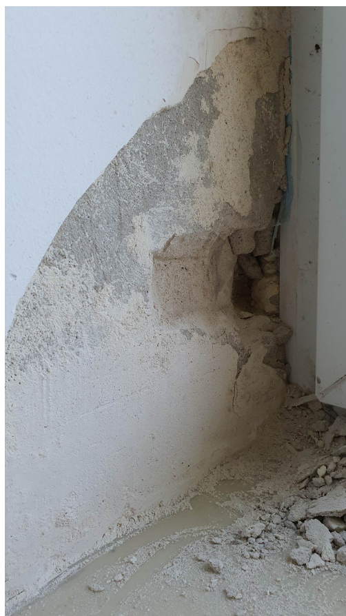
FOT. NR 4 – Odkrywka nr 2 - sprawdzenie szczelności osadzenia okien zewnętrznych w pom. nr 4
