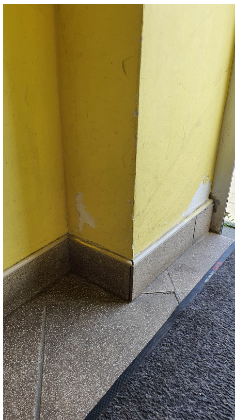
FOT. NR 9 – Odkrywka nr 5 – odpryski powłoki malarskiej przy wejściu głównym w pom. nr 1
