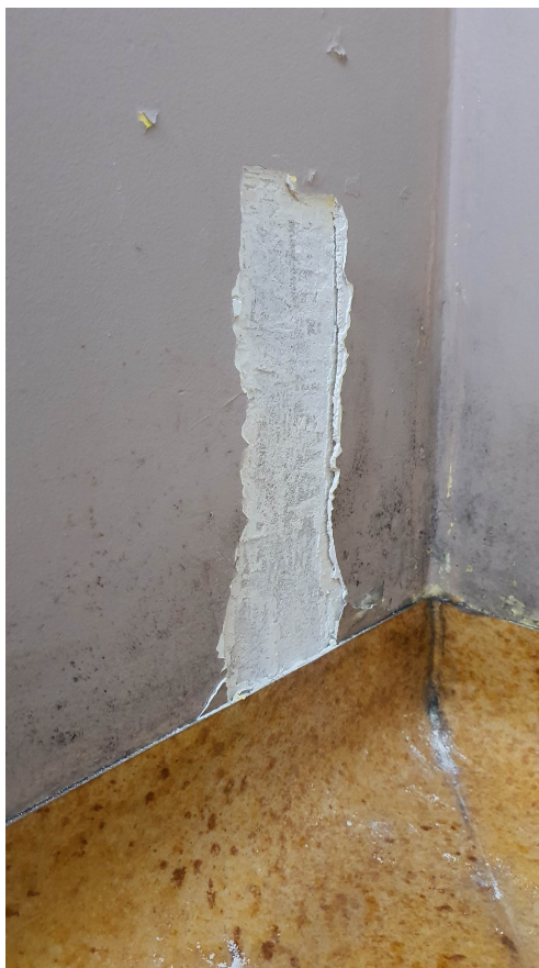
FOT. NR 8 – Odkrywka nr 6 – odspajanie się gładzi gipsowej w strefie przypodłogowej w pom. nr 3
