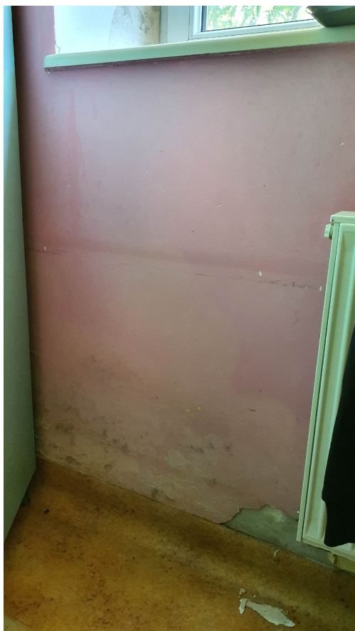
FOT. NR 13 – Odspajanie tynku przy cokole w pom. nr 4
