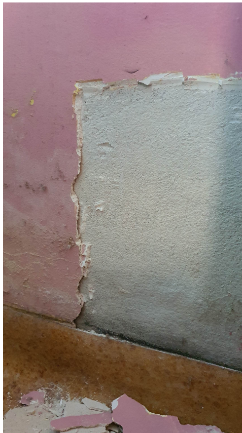
FOT. NR 7 – Odkrywka nr 5 – odspajanie się gładzi gipsowej, zasolenie ściany w strefie przypodłogowej w pom. nr 4
