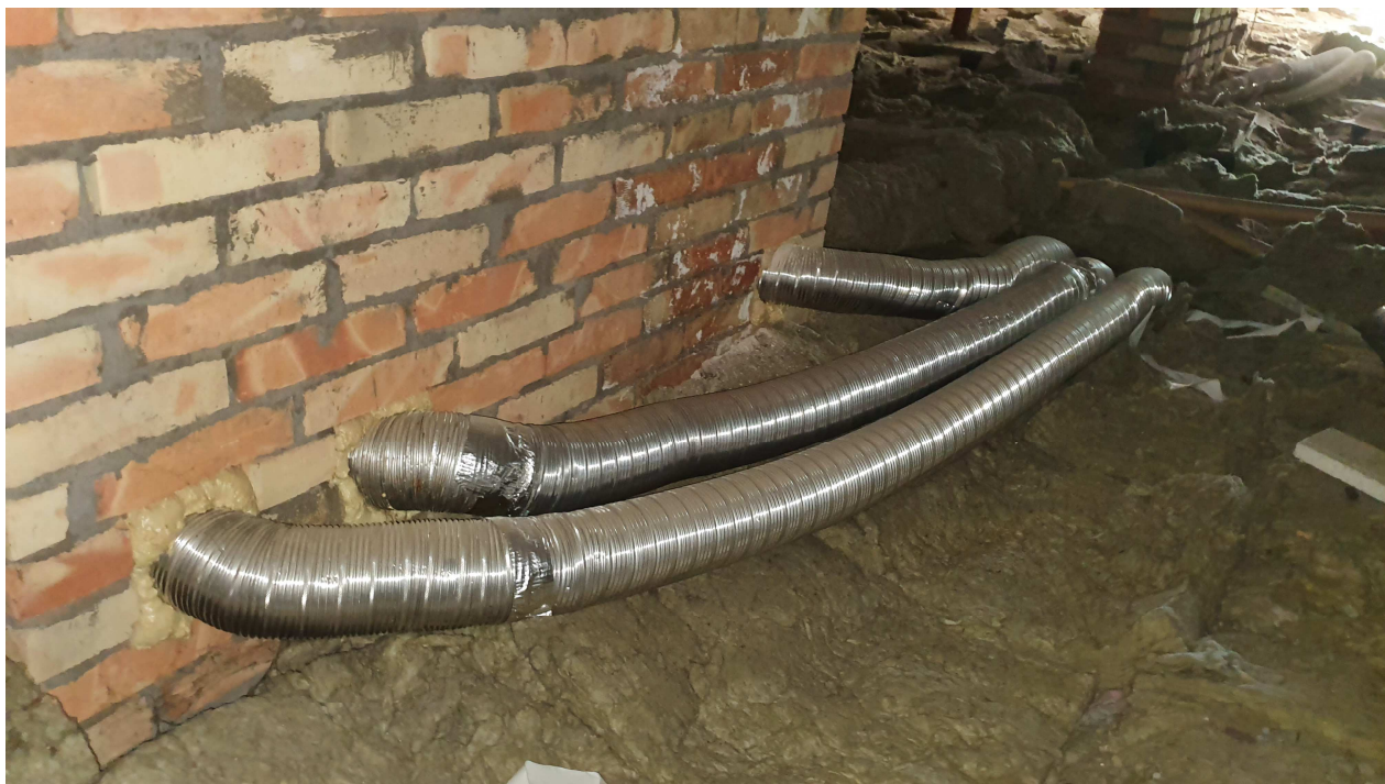
FOT. NR 25 – Przebieg kanałów wentylacyjnych na poddaszu
