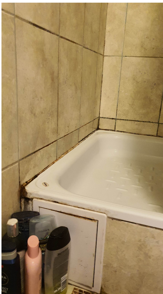
FOT. NR 20 - Naloty pleśni na spoinach silikonu i płytek ściennych pom. nr 7 (łazienka damska)
