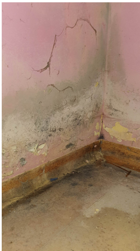
FOT. NR 14 – Ślady pleśni i odspojenia powłoki malarskiej w dolnym narożniku ściany w pom. nr 4
