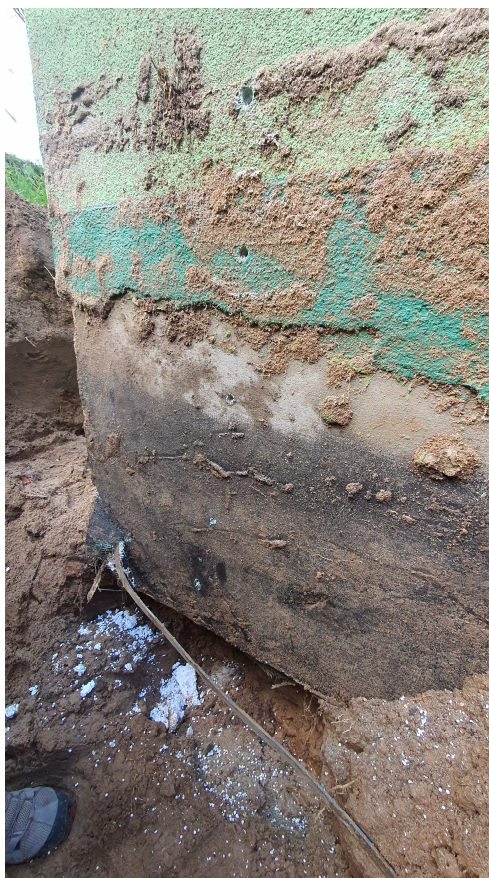
FOT. NR 3 – Odkrywka nr 1 wykop do głębokości 0,9 m w południowo-wschodnim narożniku ściany fundamentowej
