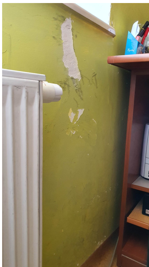
FOT. NR 10 – Odkrywka nr 5 – odpryski powłoki malarskiej przy wejściu głównym w pom. nr
