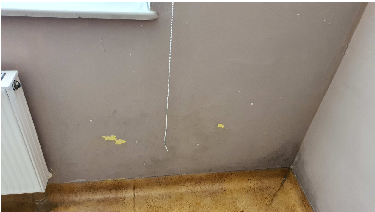
FOT. NR 11 – Odkrywka nr 5 – odpryski powłoki malarskiej przy wejściu głównym w pom. nr 1
