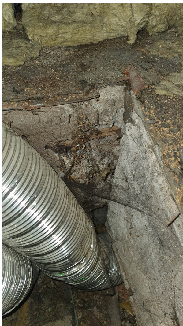
FOT. NR 26 – Przebieg kanałów wentylacyjnych na poddaszu
